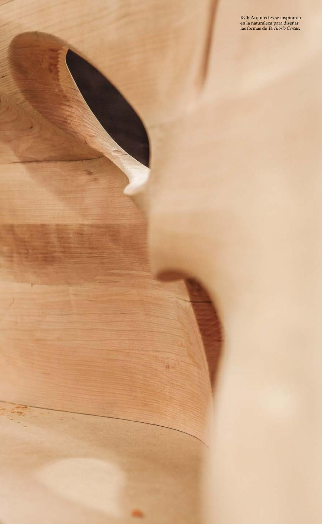
Territorio Cercas se fabricó con una máquina de control numérico o CNC. El proceso de fabricación en CNC comienza con una imagen digital en tres dimensiones (en este caso el diseño proporcionado por RCR Arquitectes). A continuación la máquina CNC transforma esta imagen y la mecaniza mediante un sistema de coordenadas que determinan el movimiento de la herramienta de corte.
